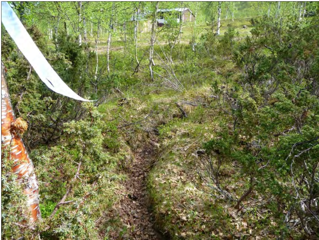
Bild 3 (ovan) och bild 4 (nedan), tagna från 1462877/7311635 mot NÖ (bild 3) och mot SÖ (bild 4). Kanalen är torrlagd, här ca 0,3 m bred och 0,2 m djup, med uppbyggd vall, 1,5 m bred och 0,1 m hög utefter den sida som sluttar nedåt.
