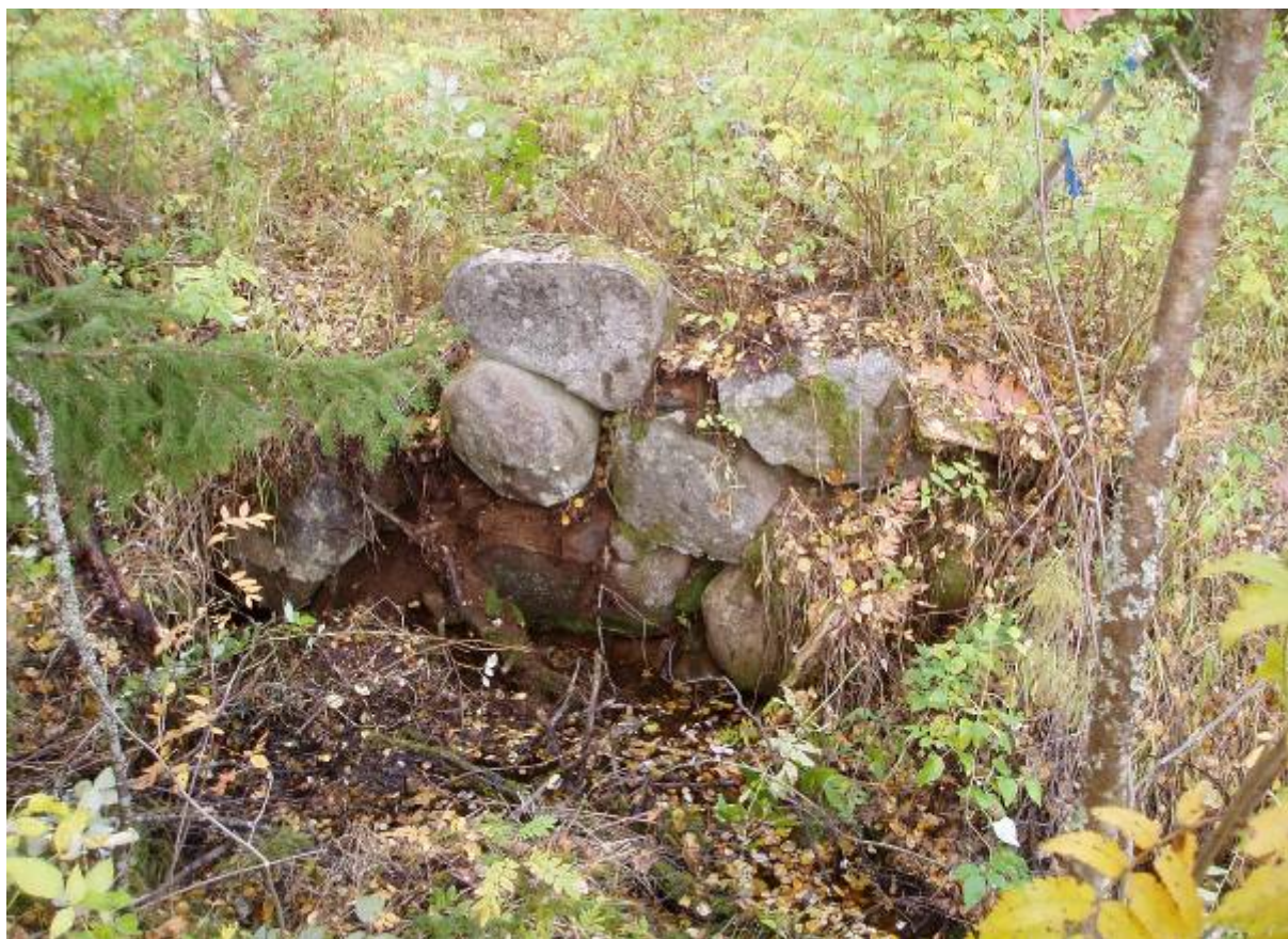
Ett fundament vid kanalens inlopp har varit del av en dammvall, som till större delen nu är borta. Bilderna tagen från SÖ. Fundamentet på bilden finns således vid kanalens nordvästra sida.
