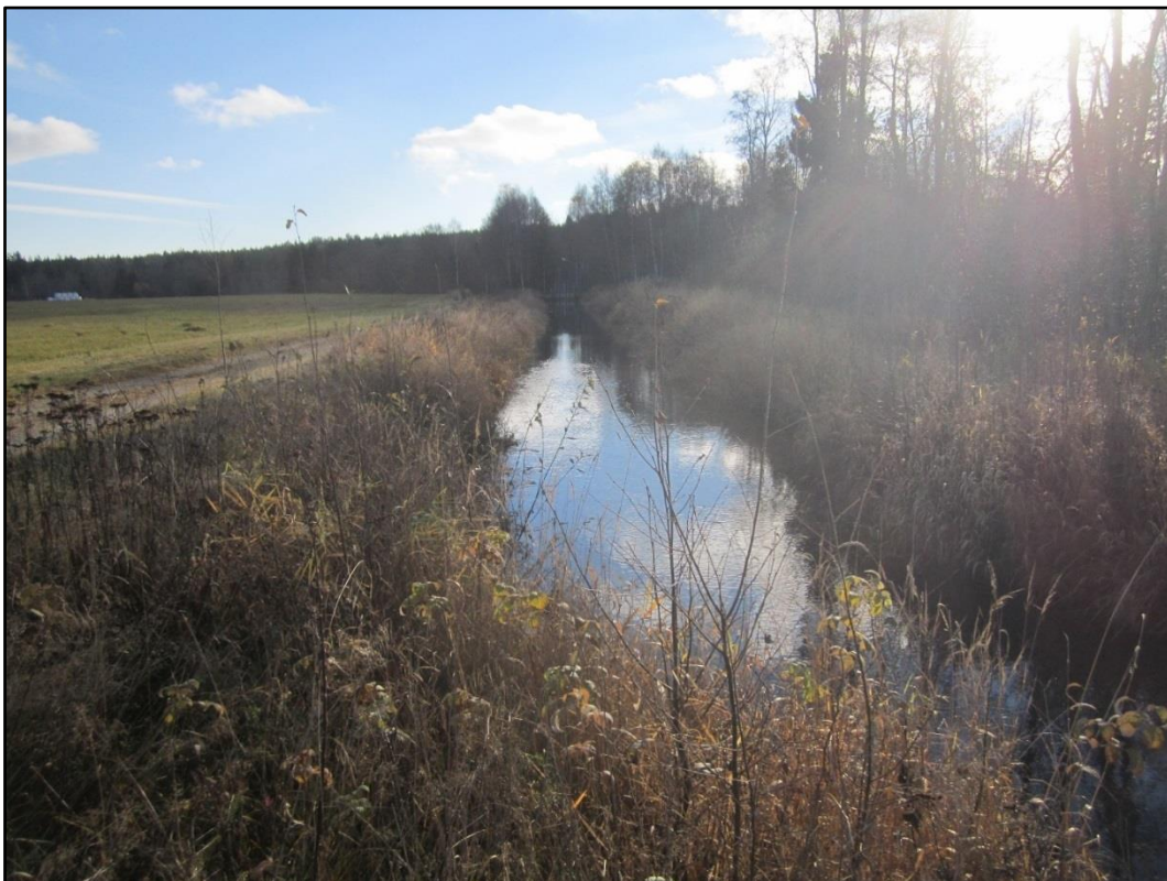
Figur 4. Kanalen mot inloppet till den kulverterade tuben vid Gällsta kraftstation. Foto från V: Ola Nilsson 2016.
