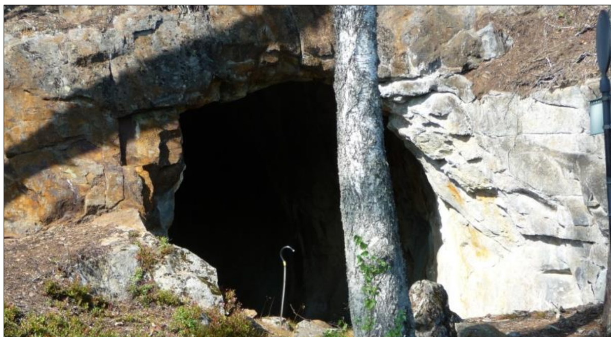
Gruvhål från 1600-talet – fornlämning värd att bevara. Foto Lennart Klang 2010.
